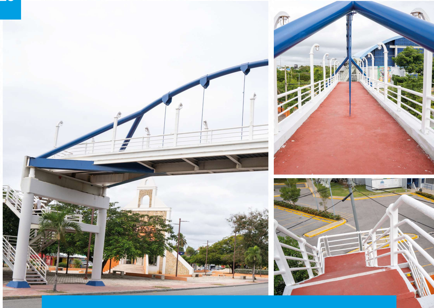
REMOZAMIENTO PUENTE PEATONAL
