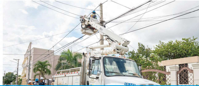
+600 LÁMPARAS LED INSTALADAS
